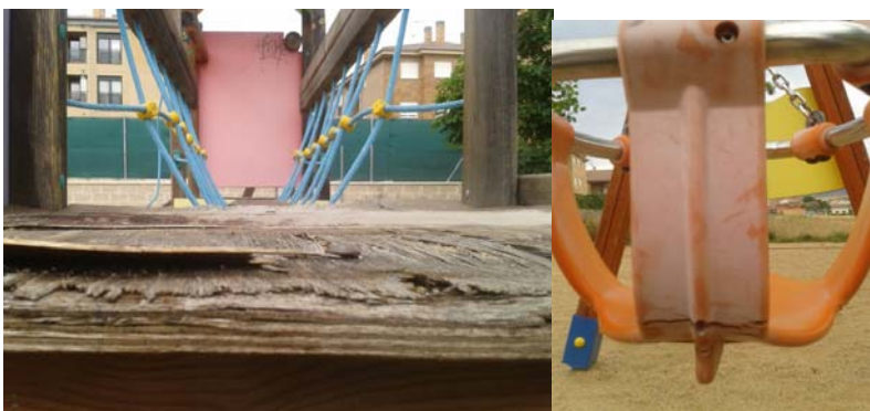
Desperfectos peligrosos en columpios
